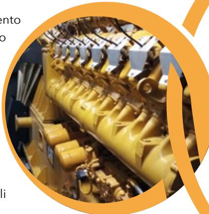
Le caratteristiche costruttive sono ad alta efficienza e performance ambientali. I due Gruppi, infatti, presentano già da progetto minori emissioni di inquinanti (CO<sub>2</sub> < 90 mg/Nm<sup>3</sup>, e NOX < 250 mg/Nm<sup>3</sup>).
