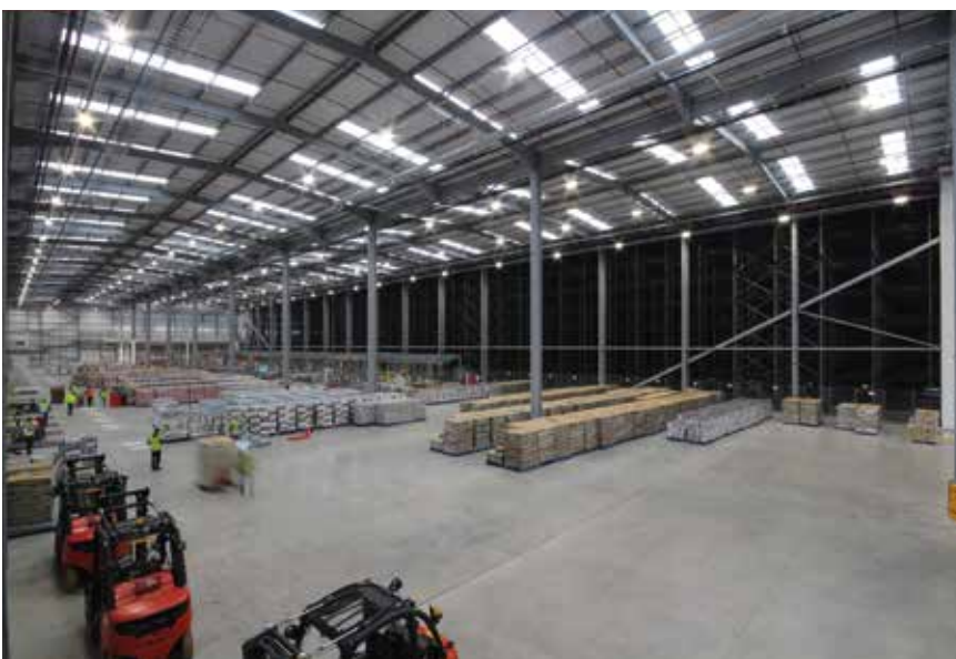
LDH Sproughton Warehouse, il magazzino automatizzato realizzato a Ipswich, UK.
